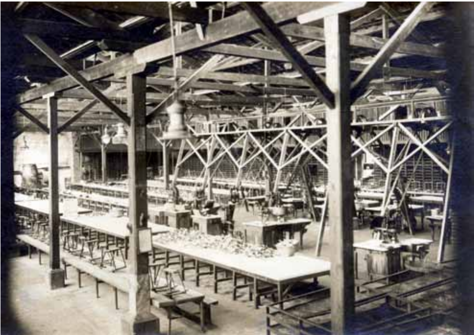
Interior de la Fábrica de Curbera en la Ría de Vigo
